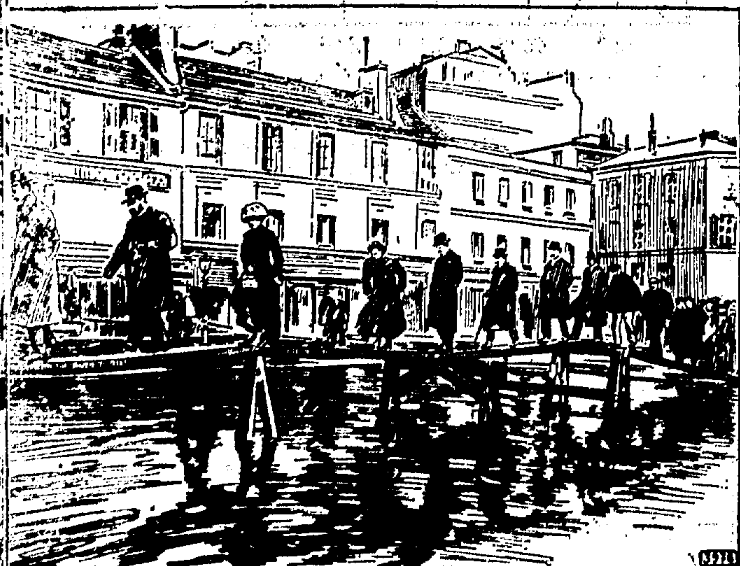
Unprezigierte Holzbrücken in den überschwemmten Straßen.
