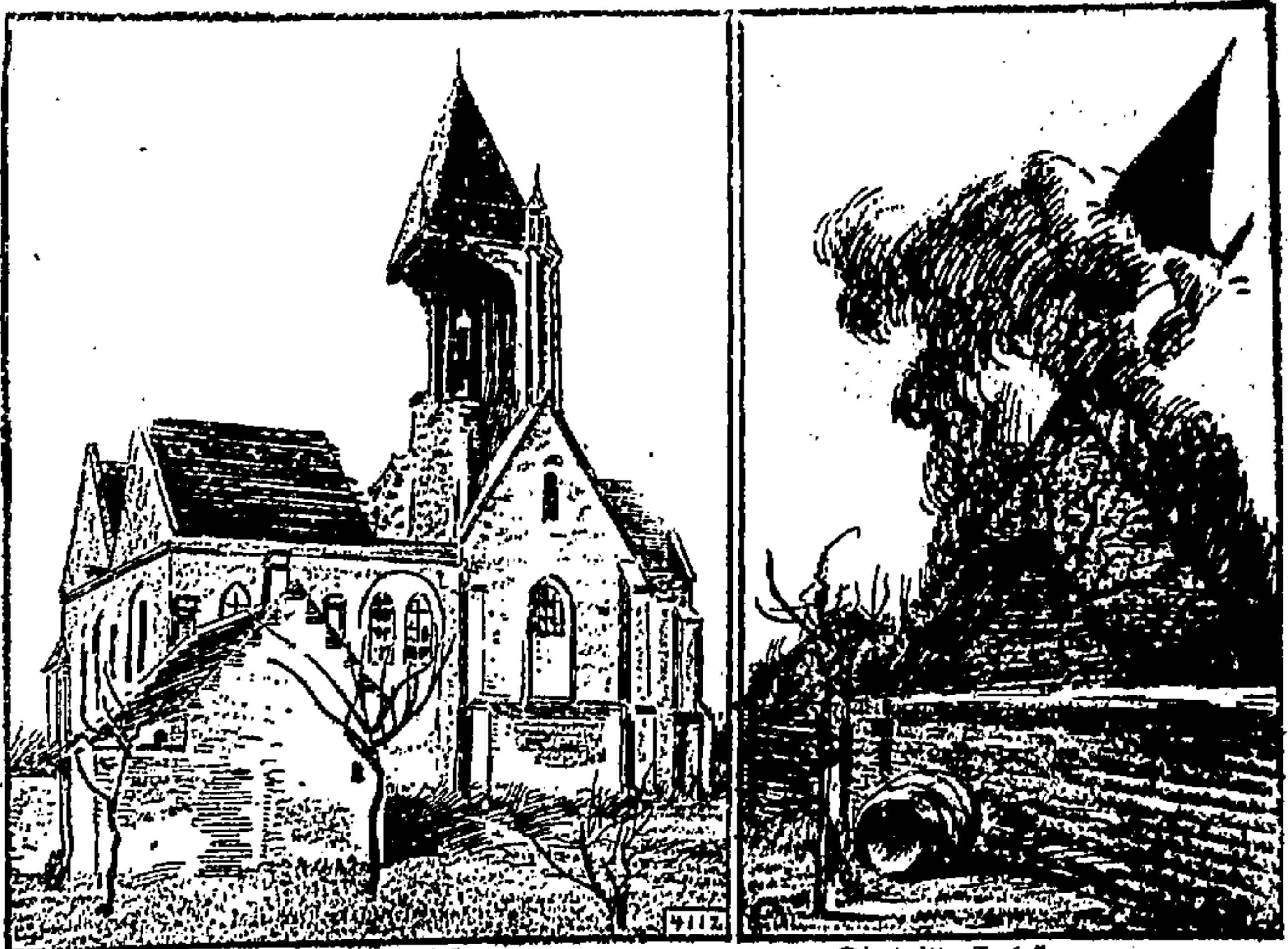
Wirkung der ersten Explosion.
