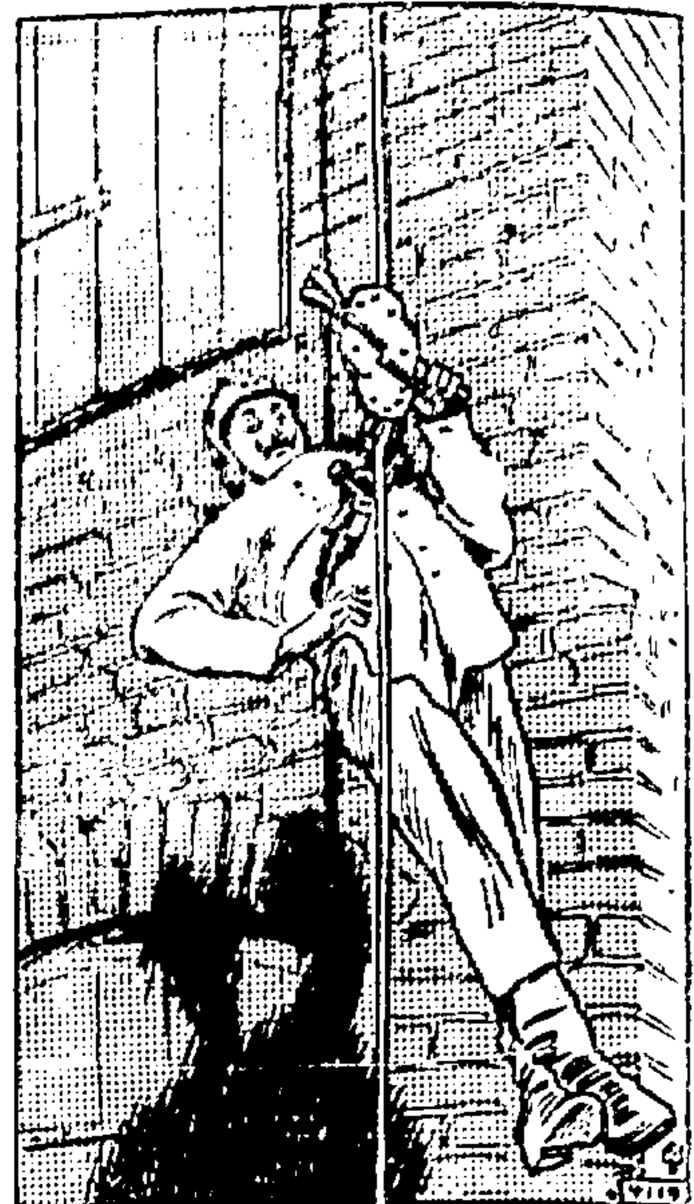
Apparat zur Rettung aus Feuergefahr. Diese einfache Vorrichtung besteht aus einer Leine und einem Gitter mit einer Rollvorrichtung. Man befestigt die Leine an irgend einem festen Gegenstand, schnallt den Gürtel um und fährt an der Leine in wenigen Sekunden gefahrlos auf die Erde hinunter. Eine doppelte Bremsvorrichtung ermöglicht es jederzeit unterwegs sofort anzuhalten.
