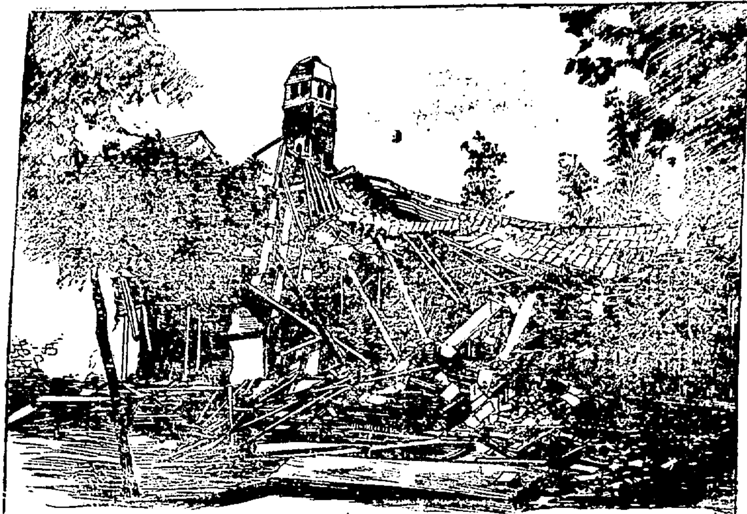
Zur Hochwasserkatastrophe in Mähren. Ein eingestürztes Haus im Orte Kunowitz.
