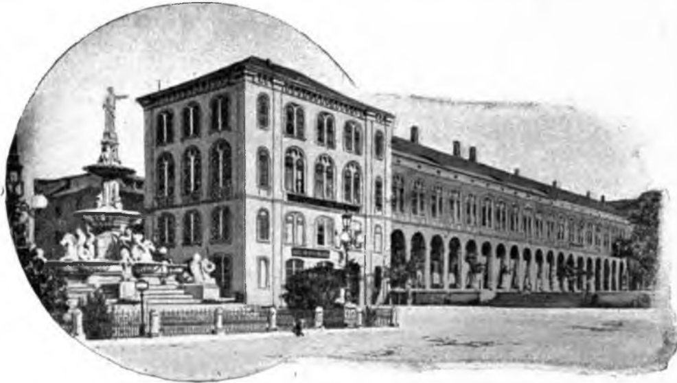
Hotel de la Ville in Spalato.
