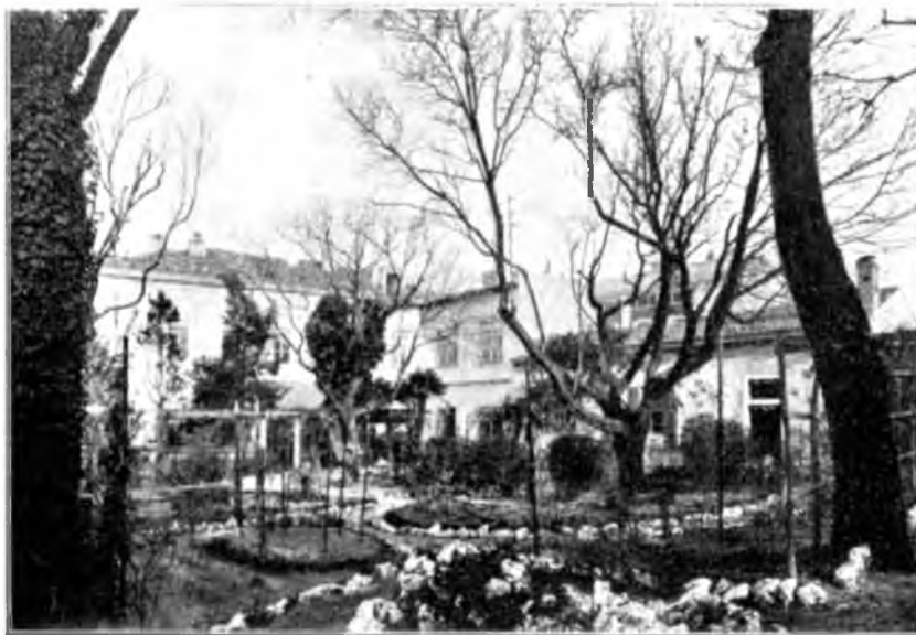
Hofraum der Station.
