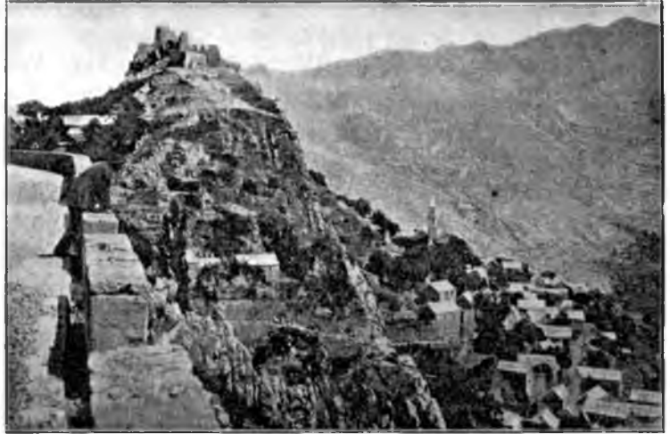
Clissa bei Spalato.
