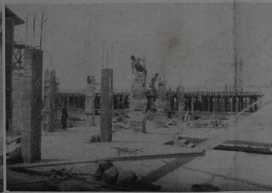
Torino - Le prime strutture già realizzate
