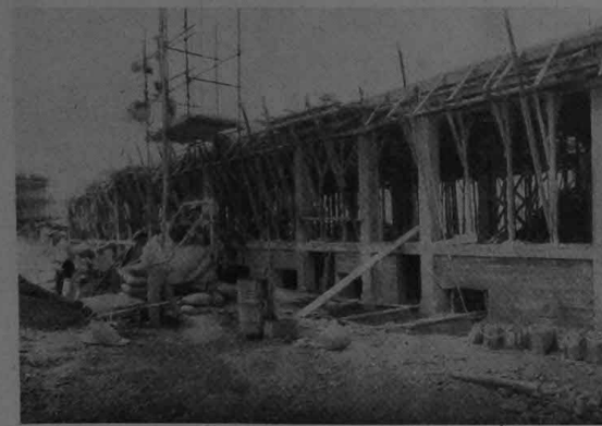
Torino - Visione del cantiere di costruzione
