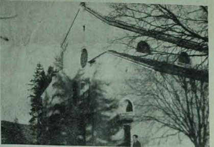
Facciata del Duomo (Valdinò 1930)
