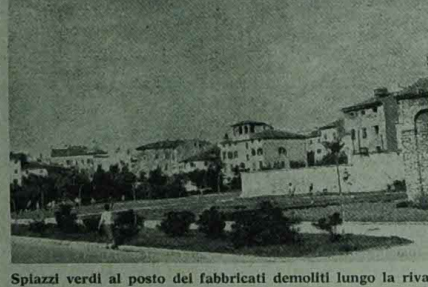
Splazzi verdi al posto dei fabbricati demoliti lungo la riva
