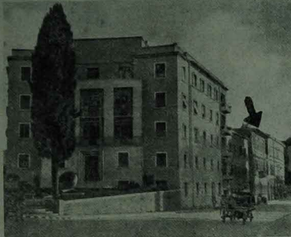
L'edificio contrassegnato dalla freccia, in via Arena, fu la prima sede del Ginnasio Italiano di Pola dal 1908 al 1915
