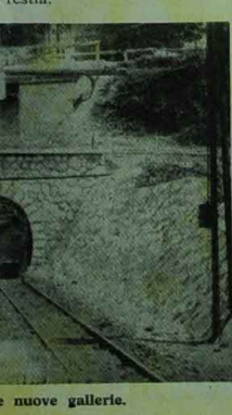
L'imbocco delle nuove gallerie.
