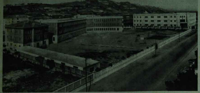
Il complesso edilizio dell'Opera di Padre Damiani
